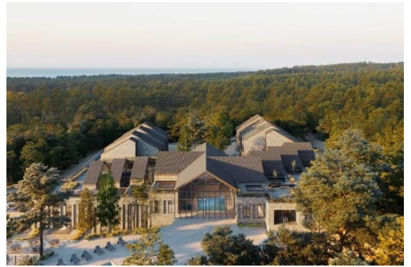
Pradėti komplekso „Auksinės kopos“ rekonstrukcijos darbai
