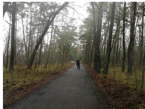
Suplanuoti pėsčiųjų ir dviračių tako Nidoje rekonstrukcijos darbai
