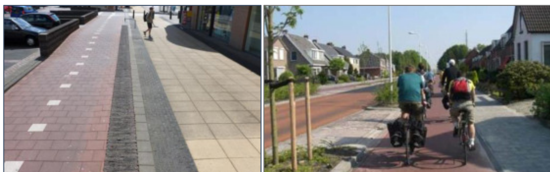
3.67 pav. Dviračių takų įrengimo pavyzdžiai (kairėje – takas atskirtas juntamos tekstūros juosta, dešinėje – dviračių takas įgilintas pėsčiųjų tako atžvilgiu)
