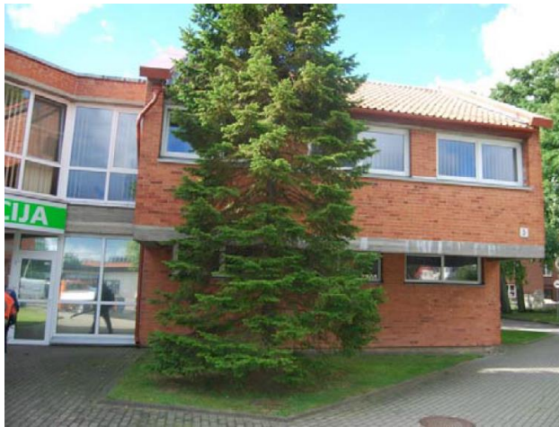
Pav. 13 „Policijos komisariatui priklausanti dalis (projektuojama kitu projektu), vaizdas iš šiaurės pusės. 2015 m.“
