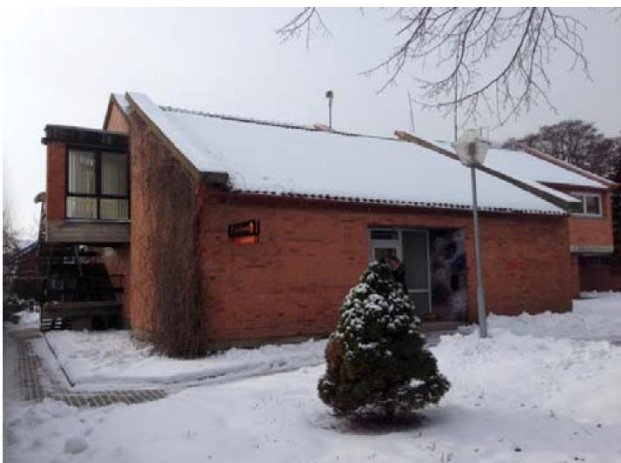
Pav. 5 „korpusas un. Nr. 2399-3000-5010:0004. Vaizdas iš šiaurės pusės. 2015 m.“
