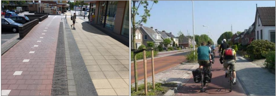
60 pav. Dviračių takų įrengimo pavyzdžiai (kairėje – takas atskirtas juntamos tekstūros juosta, dešinėje – dviračių takas įgilintas pėsčiųjų tako atžvilgiu)
