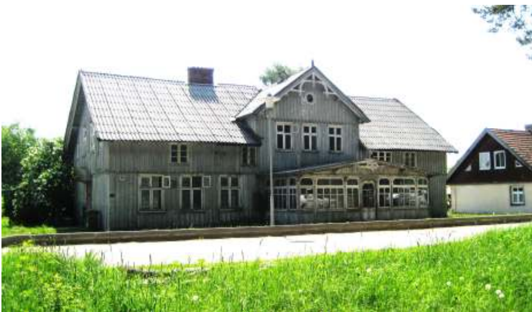
Taip pastatas atrodo šiuo metu. Susidėvėjusi čerpių danga, siekiant apsaugoti pastato medines konstrukcijas, buvo pakeista į asbocementinių lakštų dangą.
