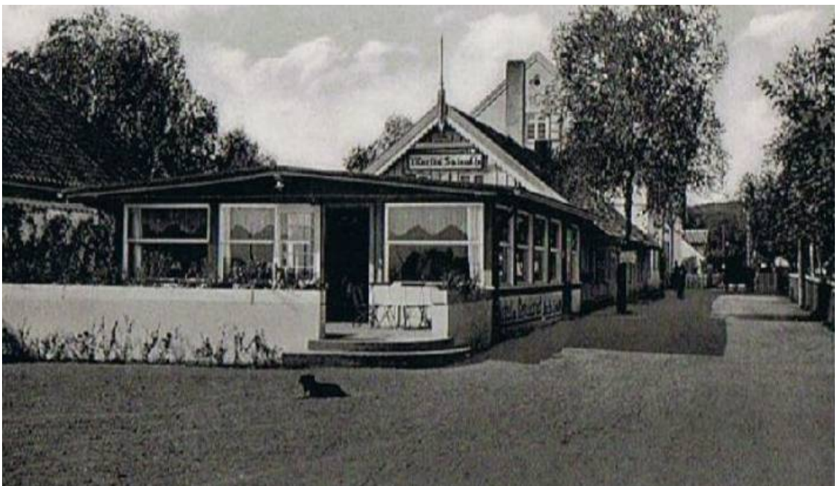
2.5.4. pav. Naujasis mūrinis M. Sakučio viešbučio pastatas. Pastatytas 1933 m., viešbutis ir restoranas prie pat uosto buvo populiariausia miestelio vieta. Statant naują mūrinį korpusą buvo perstatyta ir veranda. Iš medinės ji tapo mūrinė su vitriniais stiklais. Senasis žvejo namas, kaip sėkmės simbolis išliko - tai buvo svarbu Nidos dailininkų kolonijos atminčiai.
