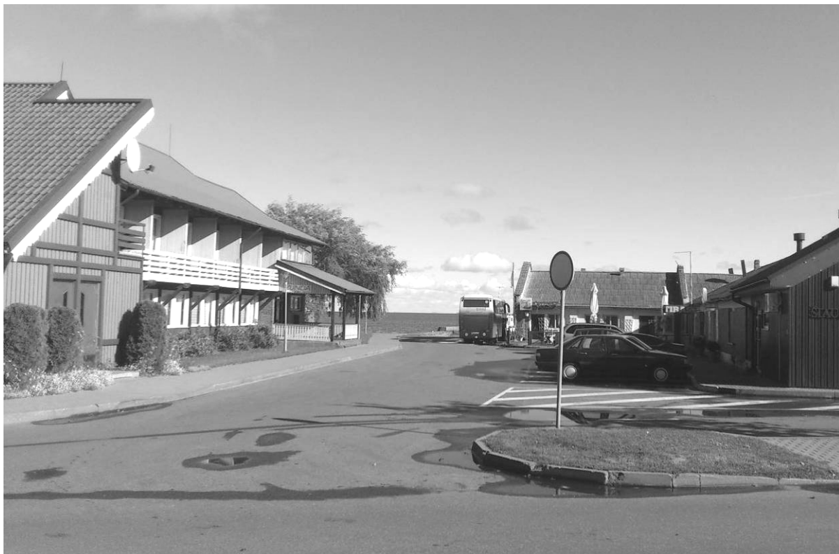
2.5.13. pav. Poilsio namai „Rasytė“ ir išlikusi buvusio žuvų turgaus erdvė Nidos centrinėje dalyje (Naglių g. 20). Dešinėje - tarybinio laikotarpio žuvies perdirbimo įmonės pastatai.
