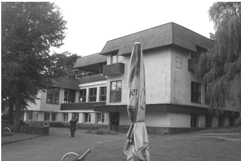
2.5.15. pav. Dabartinis rekonstruoto restorano pastato Naglių g. 31 vaizdas
