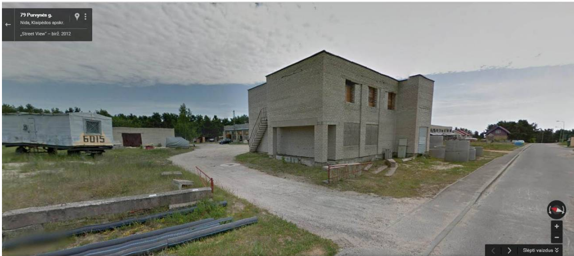
Pastatai Purvynės g. 81 ir 83 sandėliai. Pastatai silikatinių plytų, netinkuoti 1-2 aukštų, utilitarios architektūros.
