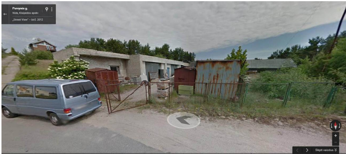
Purvynės g. 71 sandėlių kiemas, teritorija chaotiškai apstatyta metaliniais garažais ir kitais menkaverčiais statiniais, gausu nepanaudotų statybinių medžiagų ir kitų statybinių atliekų.
