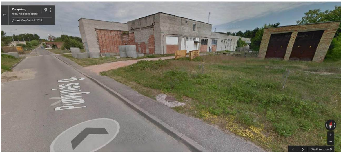
Purvynės g. 83T pastatas – transformatorinė pastotė.
