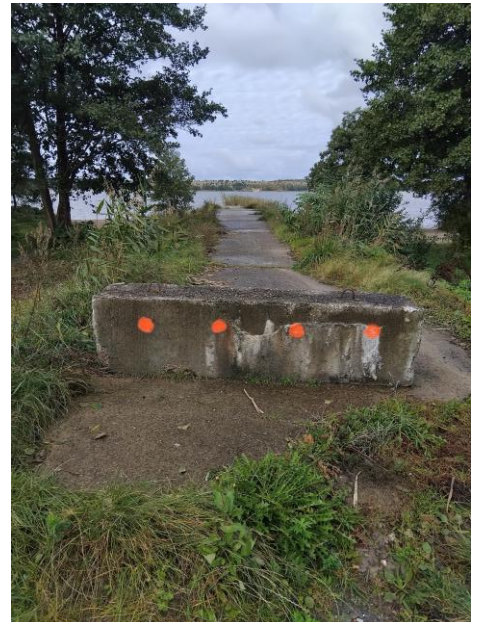
5 pav. Esamas paviršinių nuotekų - lietaus kolektorius. Sklype Unik. Nr. 4400-0778-5884.
