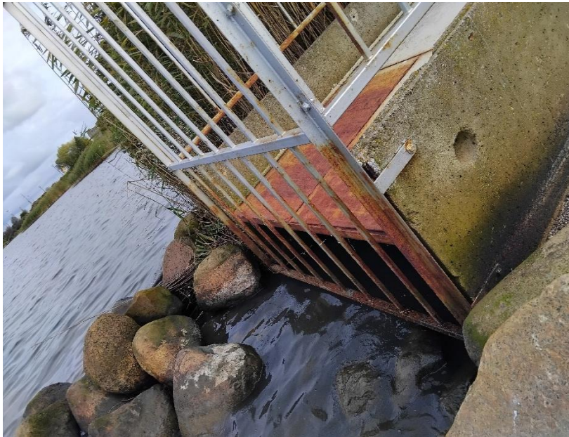
5 pav. Esamas paviršinių nuotekų - lietaus kolektorius. Sklype Unik. Nr. 4400-0778-5884.
