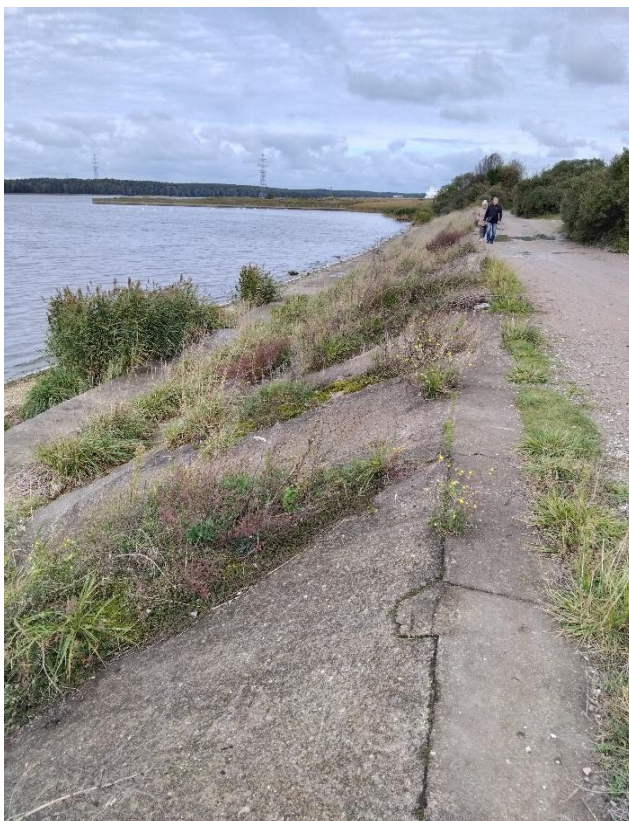
6 pav. Esami betoniniai krantosaugos statiniai.
