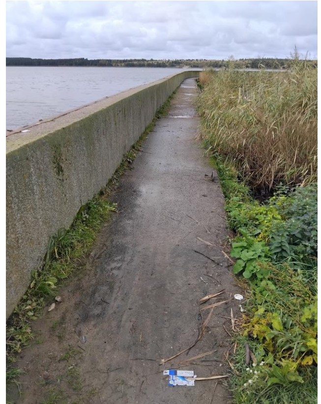
6 pav. Esami betoniniai krantosaugos statiniai.
