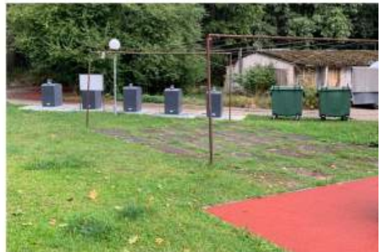
16 pav. Požemiųjų konteinerių aikštelė.
