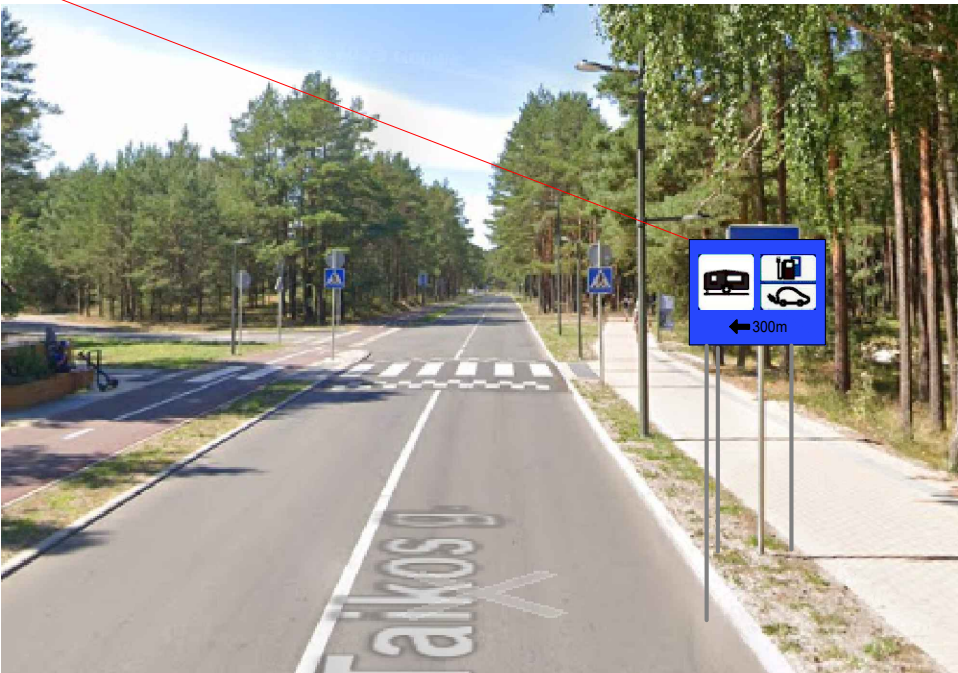
Esamas ženklas nr. 711, keičiamas nauju kombinuotu ženklu nr. 711 ir 735, dydis 0 gr., sumontuojant naujas atramas Ženklo aukštis nuo žemės lygio - 2,2m. X: 6133704,36; Y: 308975,07
