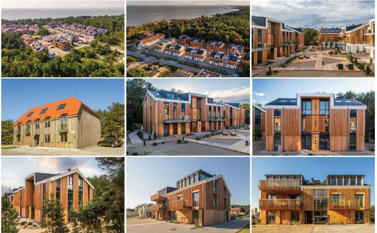
Pav. 2_Konversijos užstatymas gretimoje teritorijoje vietoje ūkio paskirties pastatų, suprojektuoti ir pastatyti poilsio ir gyvenamos paskirčių namai Vėtrungių g.
