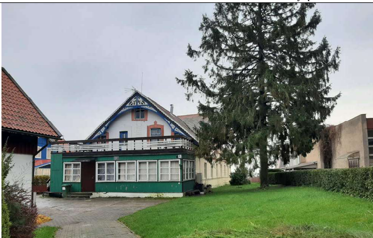
Nr. 4 Pavadinimas Šiaurės vakarų fasadas
